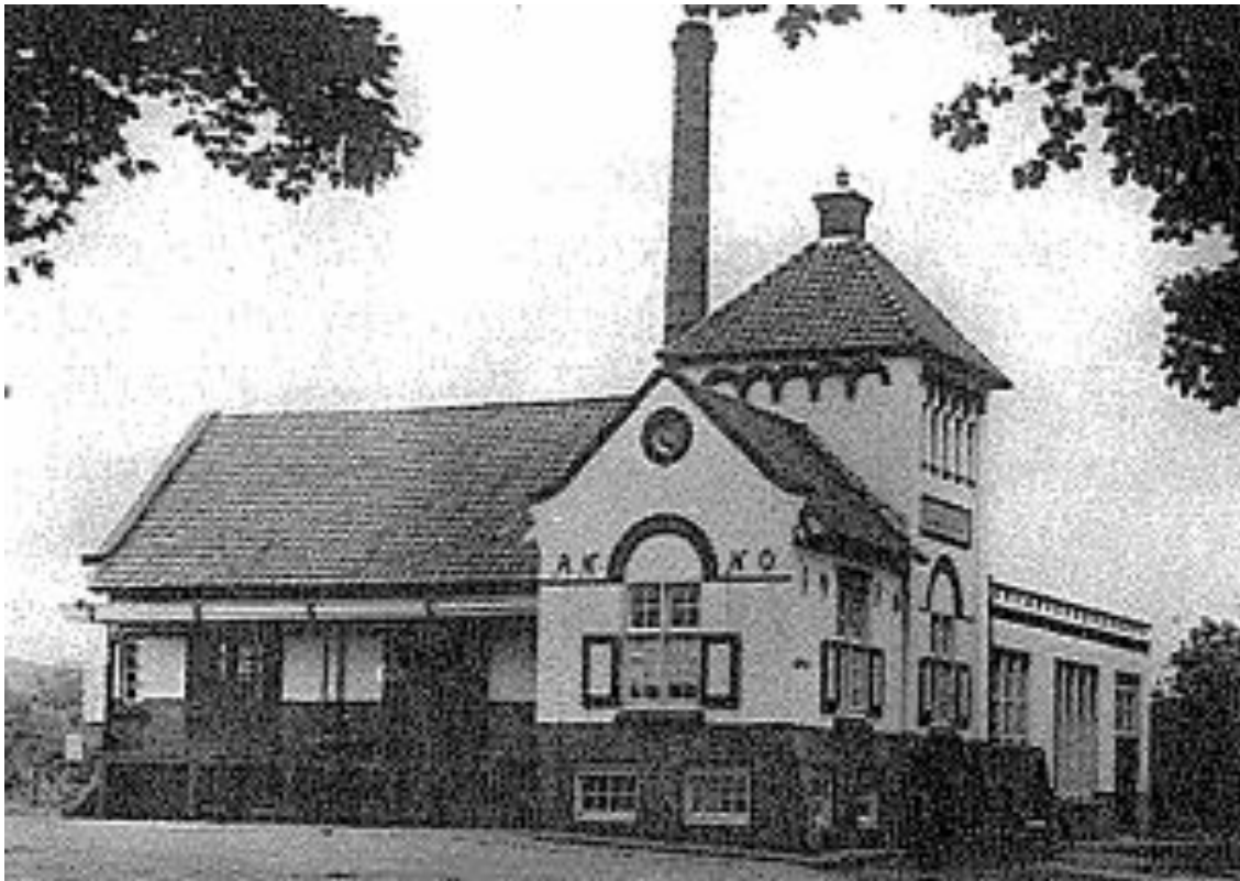
Zuivelfabriek Sint-Pancratius, Vessemsweg 1, Hoogeloon
