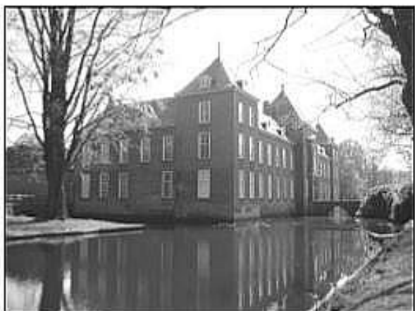
Kasteel van Heeze, voorgevel vanuit het noorden. Foto: Sjaak de Waal
